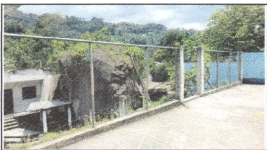
FOTO 15: Reparación de tubo hg y malla galvanizada
