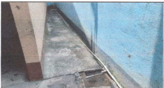
FOTO 3: Sustitución de tubería línea principal
