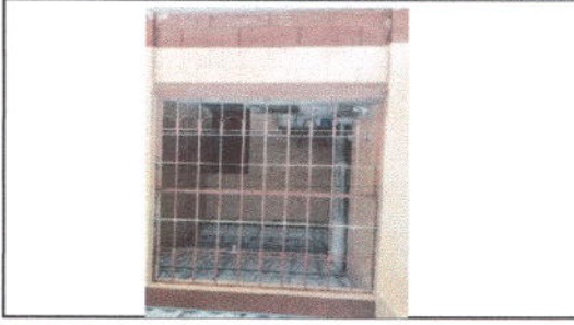
FOTO 11: Mantenimiento a balcones de metal
