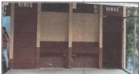
FOTO 4: Fabricación e instalación de puertas de metal en módulos
