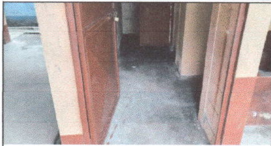
FOTO 1: Sustitución de piso de cemento liquido por piso ceramico
