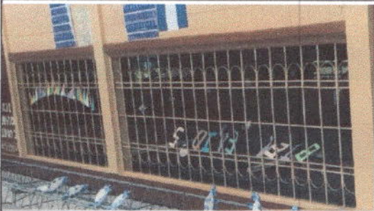
FOTO 7: Mantenimiento a balcones de metal
