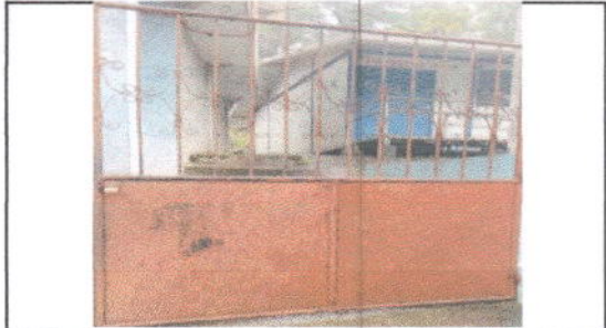
FOTO 14: Mantenimiento a portones de metal
