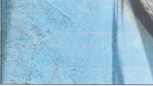
FOTO 9: Pintura en muros exteriores e interiores
